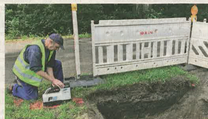
Ein Mitarbeiter der Firma Berasco erkennt per Scanner genau, wo sich der Bohrer im Erdreich befindet.
