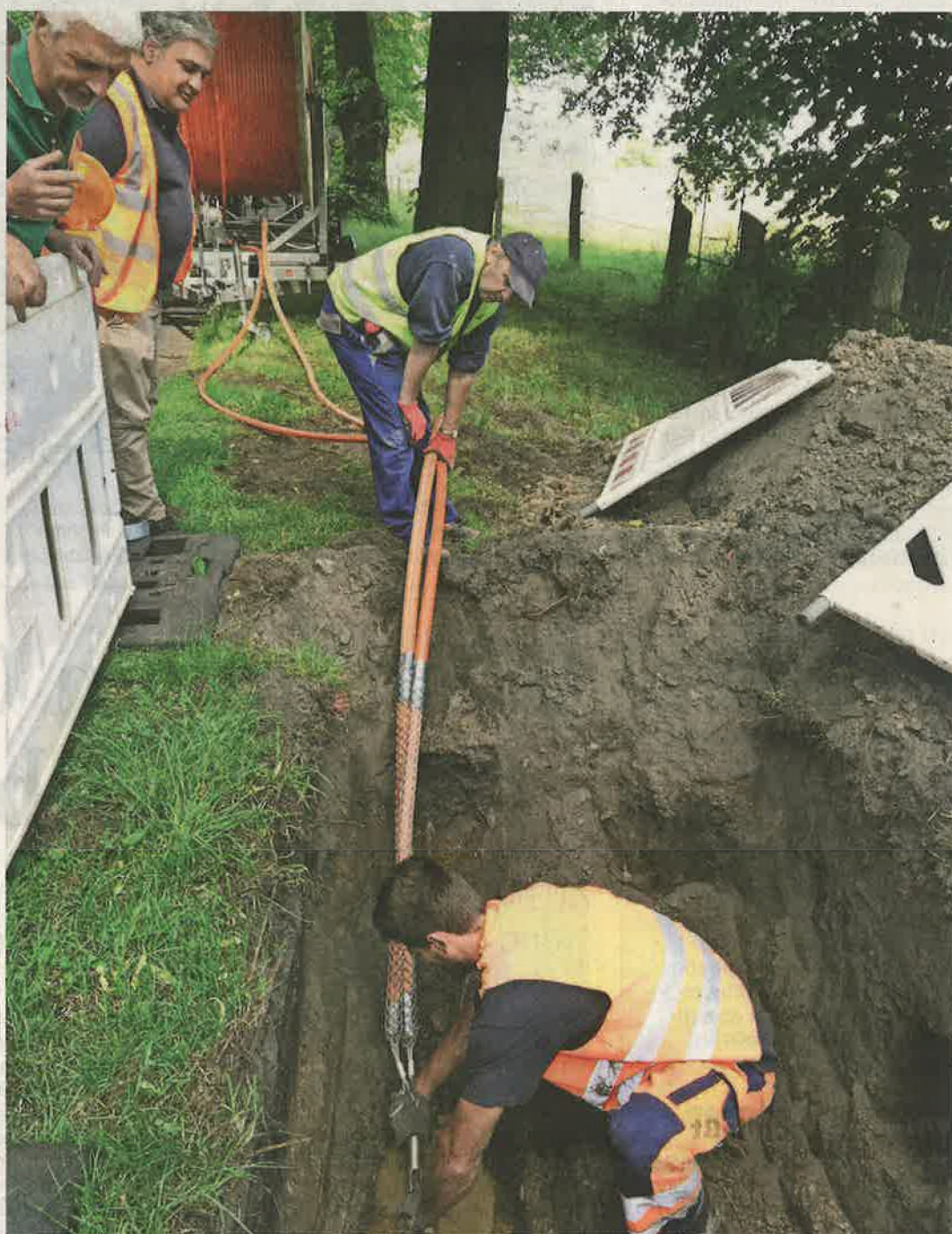
Die Leerrohre werden in das Bohrloch gezogen.
